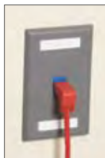
Cable hacia abajo: El clip del cable hacia abajo y el cable hacia abajo. En la ilustración: EVNSL23E-0003-DS
